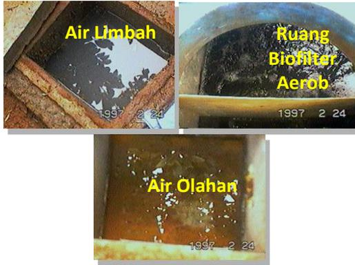
Gambar 3 : Contoh IPAL Semi-Komunal Dengan Proses Biofilter Anaerob-Aerob Kapasitas 6 m<sup>3</sup> per Hari.
